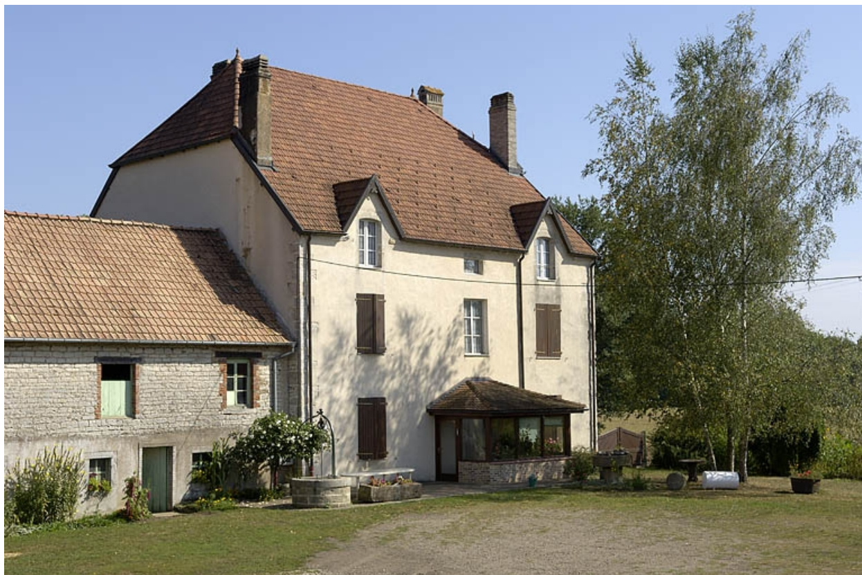
Ancien logement patronal.
