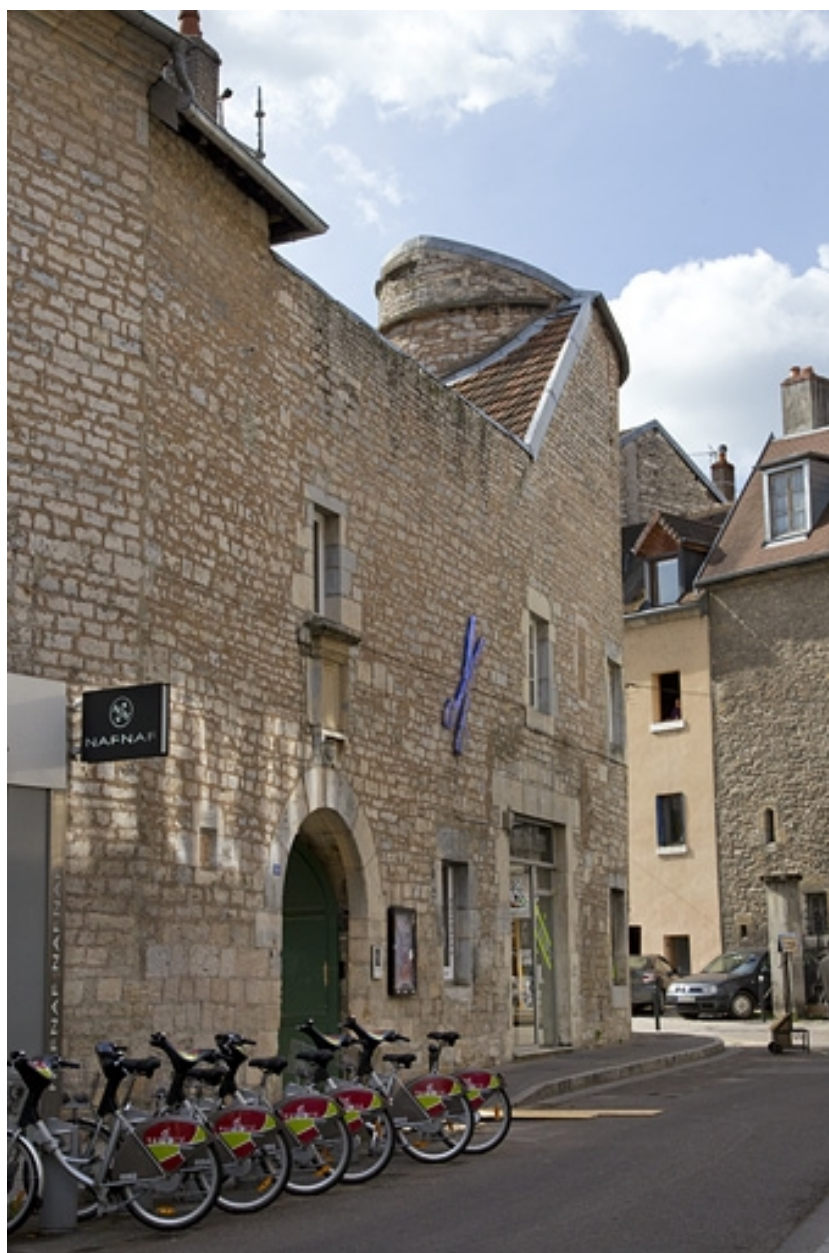
Façade latérale droite : de trois quarts gauche.
