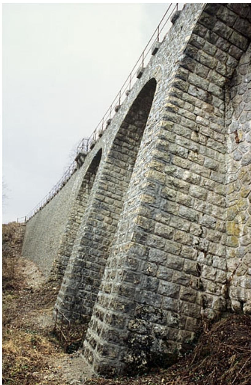
Talus du mur au niveau des arcades.
