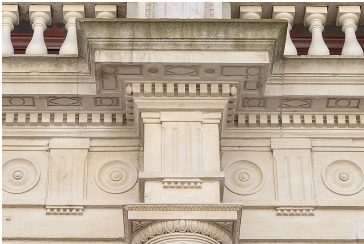
Façade antérieure, rez-de-chaussée : morceau d'entablement.
