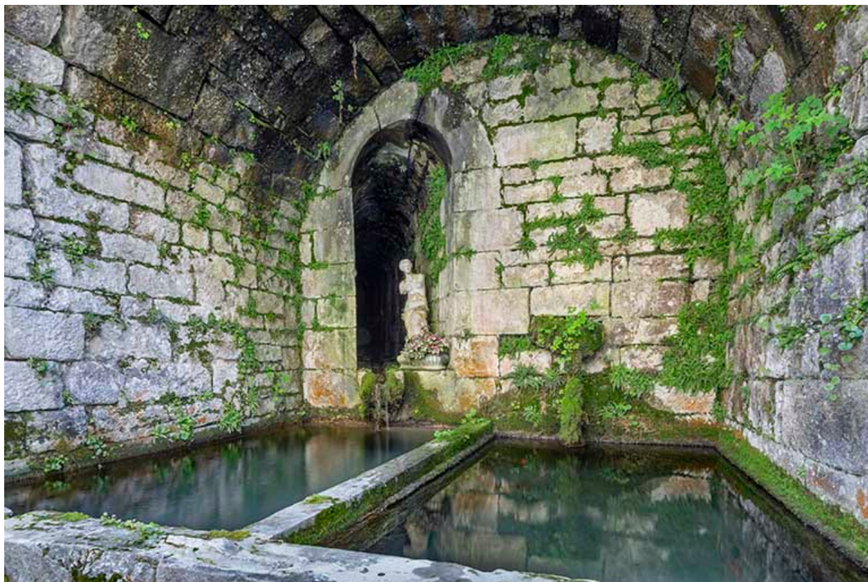
Détail du vivier et du conduit d'amenée.
