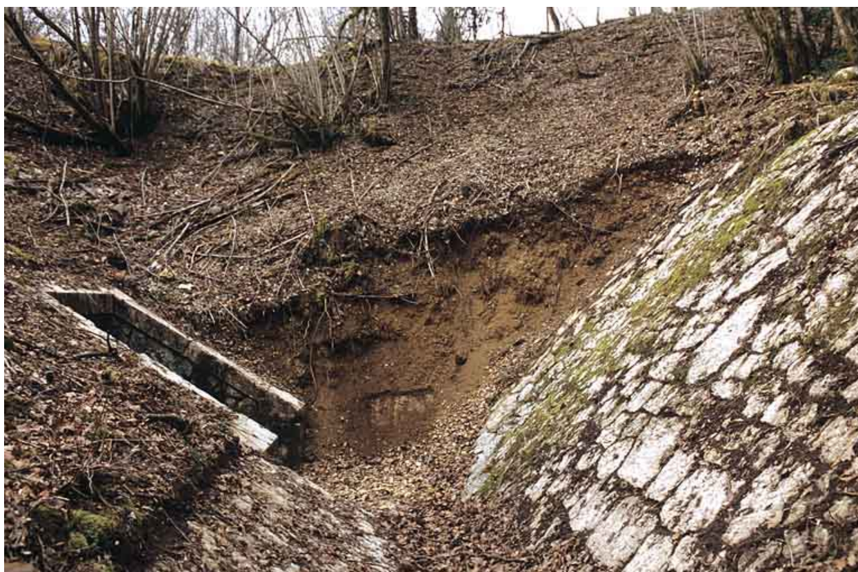
Aqueduc : " canal " et tête amont.
