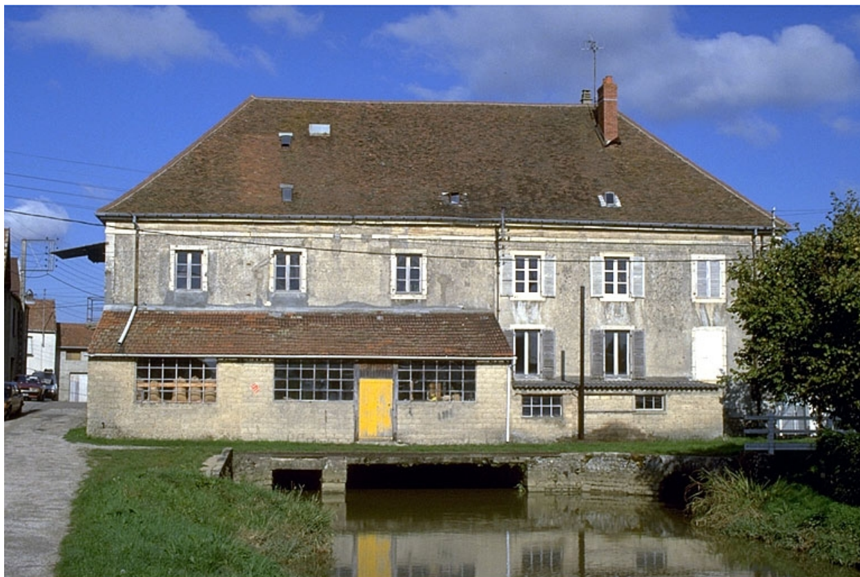
Façade postérieure de la minoterie.
