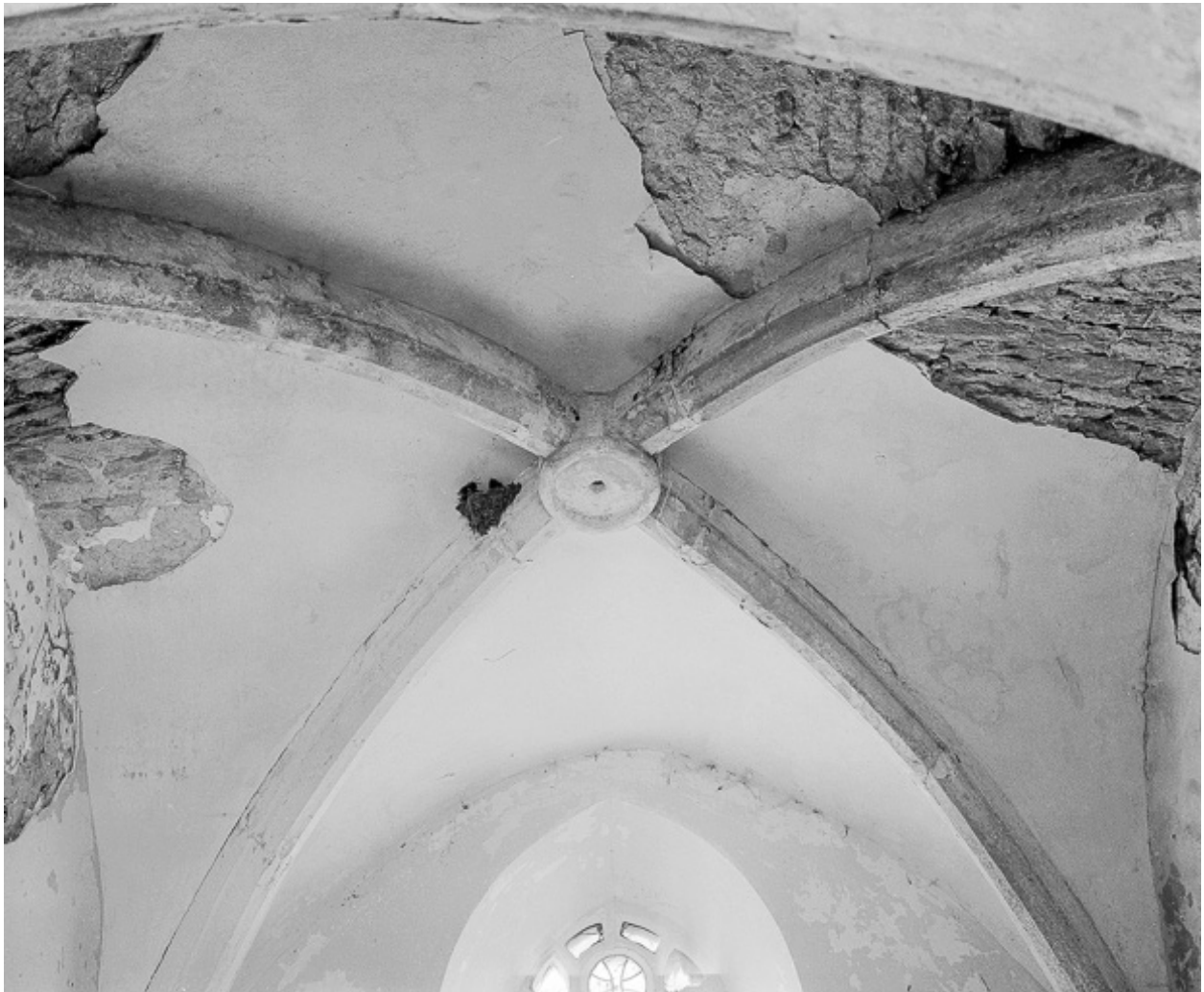
Intérieur : voûte de la chapelle latérale droite.
