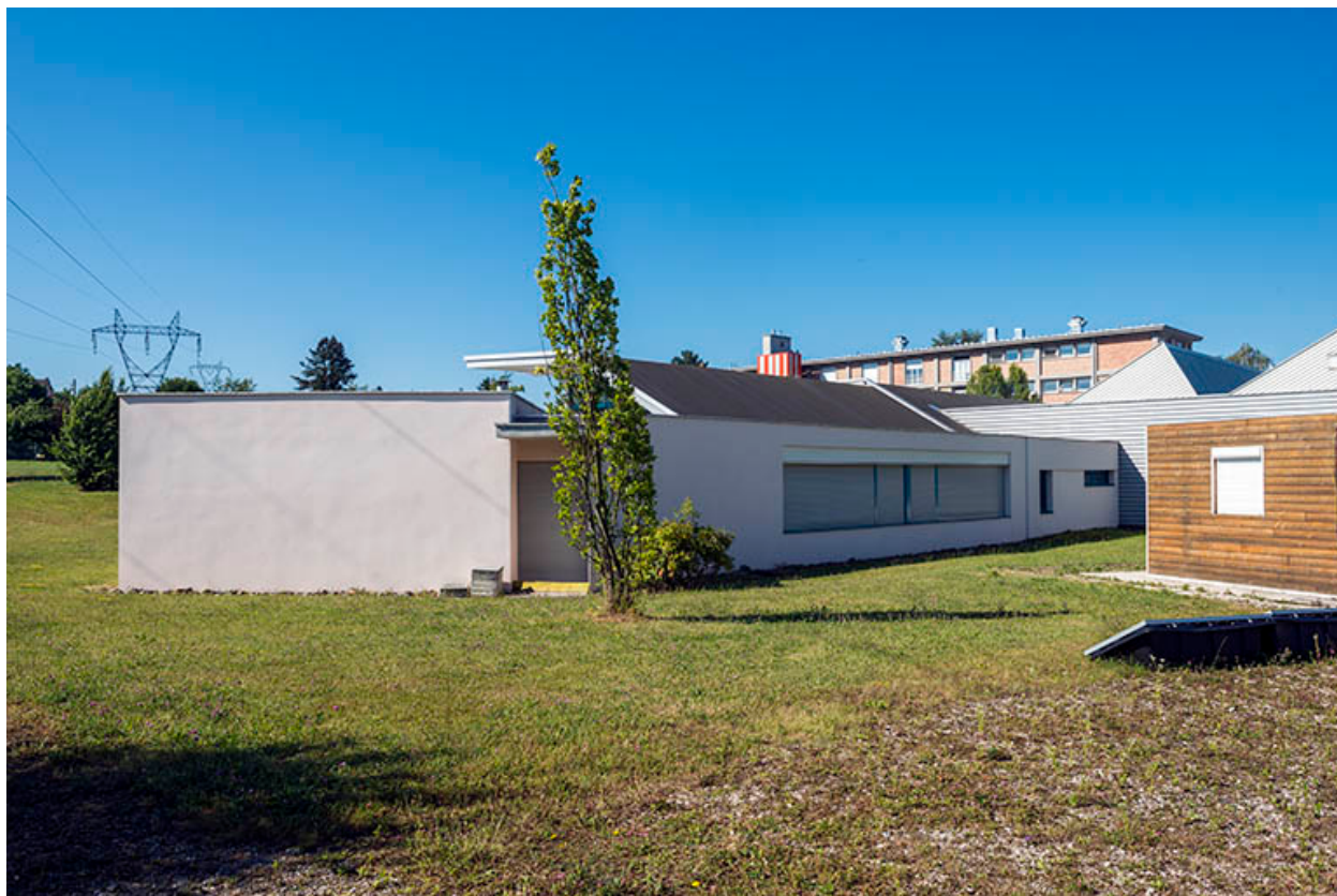
Façade postérieure nord de la plasturgie. (ex-Léger)
