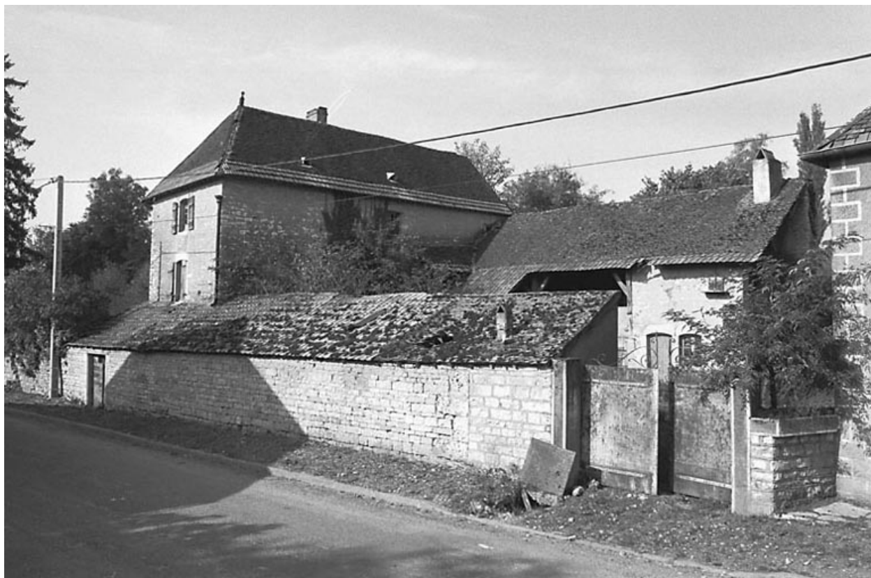
Chenevrey-et-Morogne : maison de vigneron située rue d'Aval.
