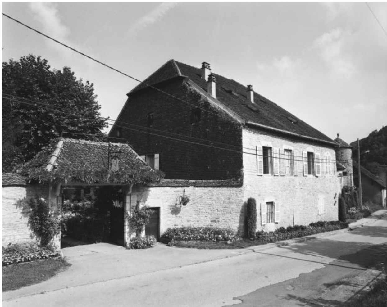
Bâtiment d'habitation vu depuis la rue.
