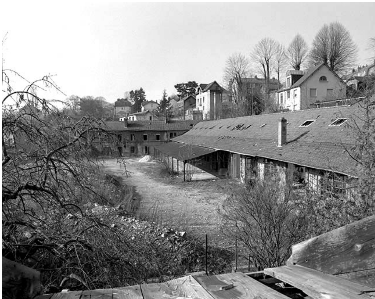
Logement d'ouvriers (21) et menuiserie.
