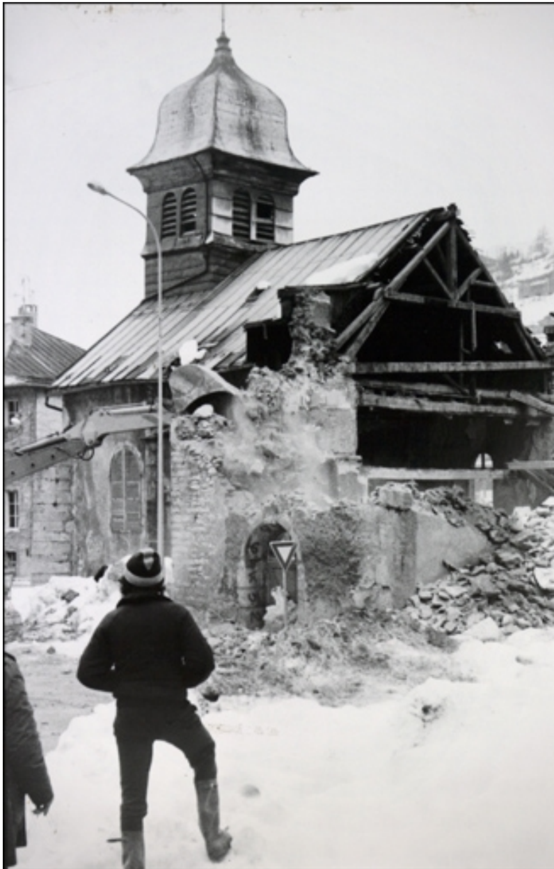
[Démolition du chœur de l'église], 1981
