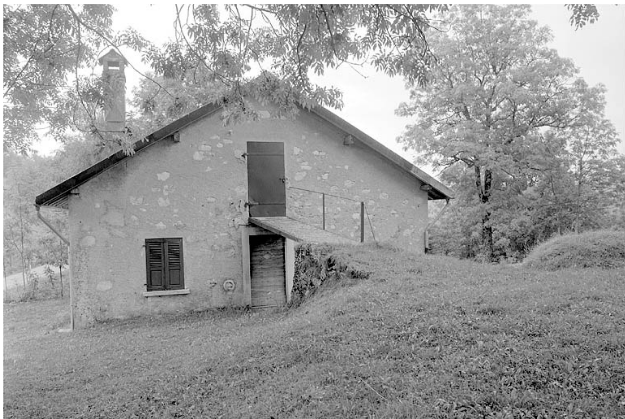
Face sud-ouest de la porcherie.
