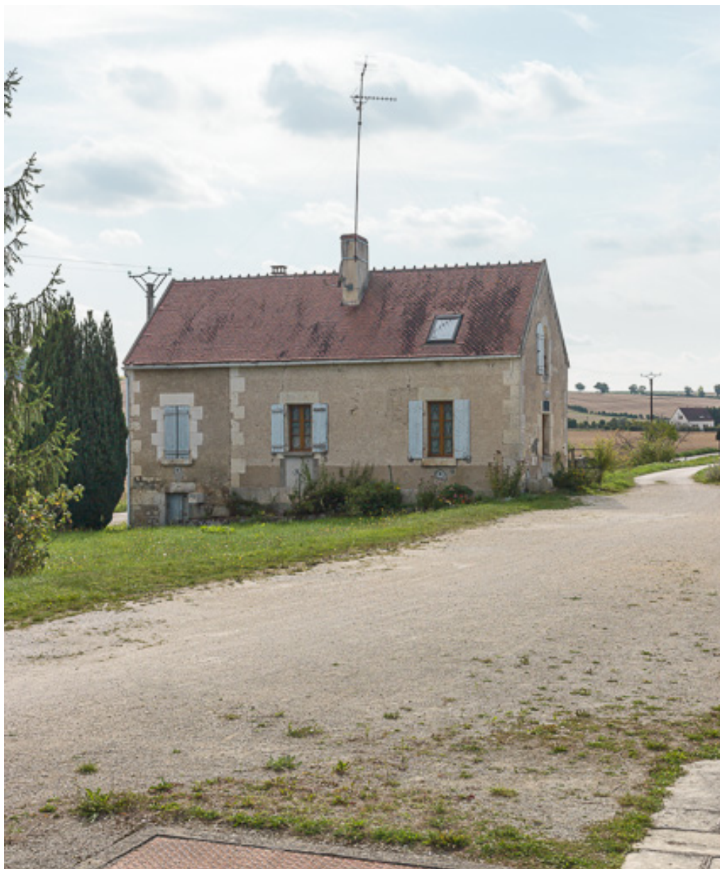
Vue de la maison éclusière.
