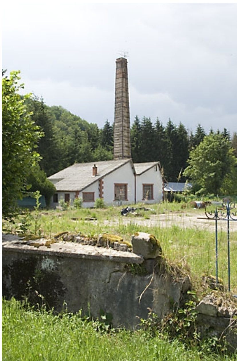
Atelier de réparation et cheminée depuis l'est.
