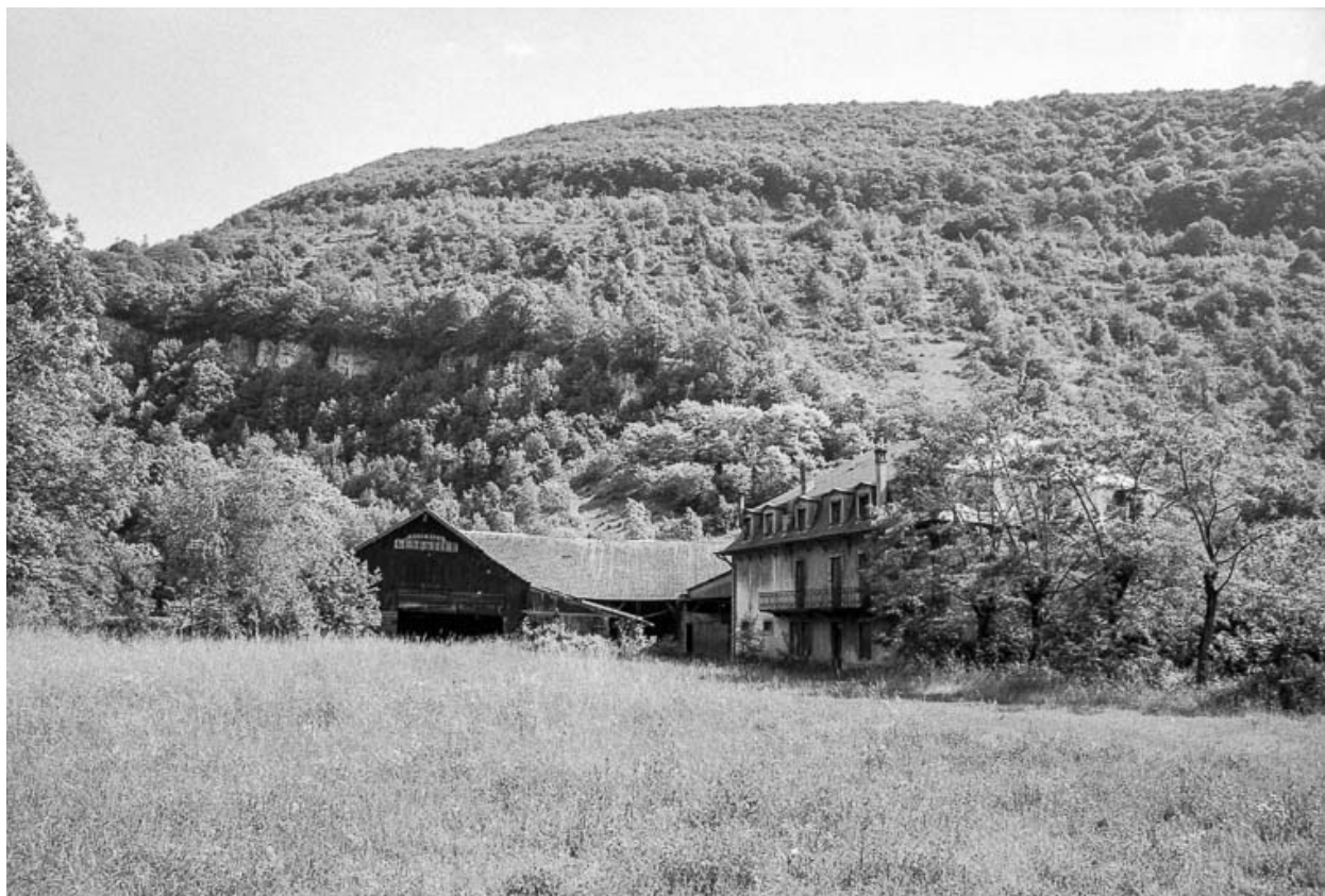
Vue d'ensemble depuis le sud en 1980.
