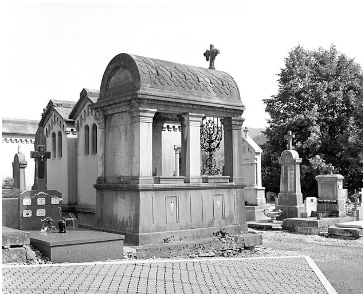
Façades postérieure et latérale gauche.
