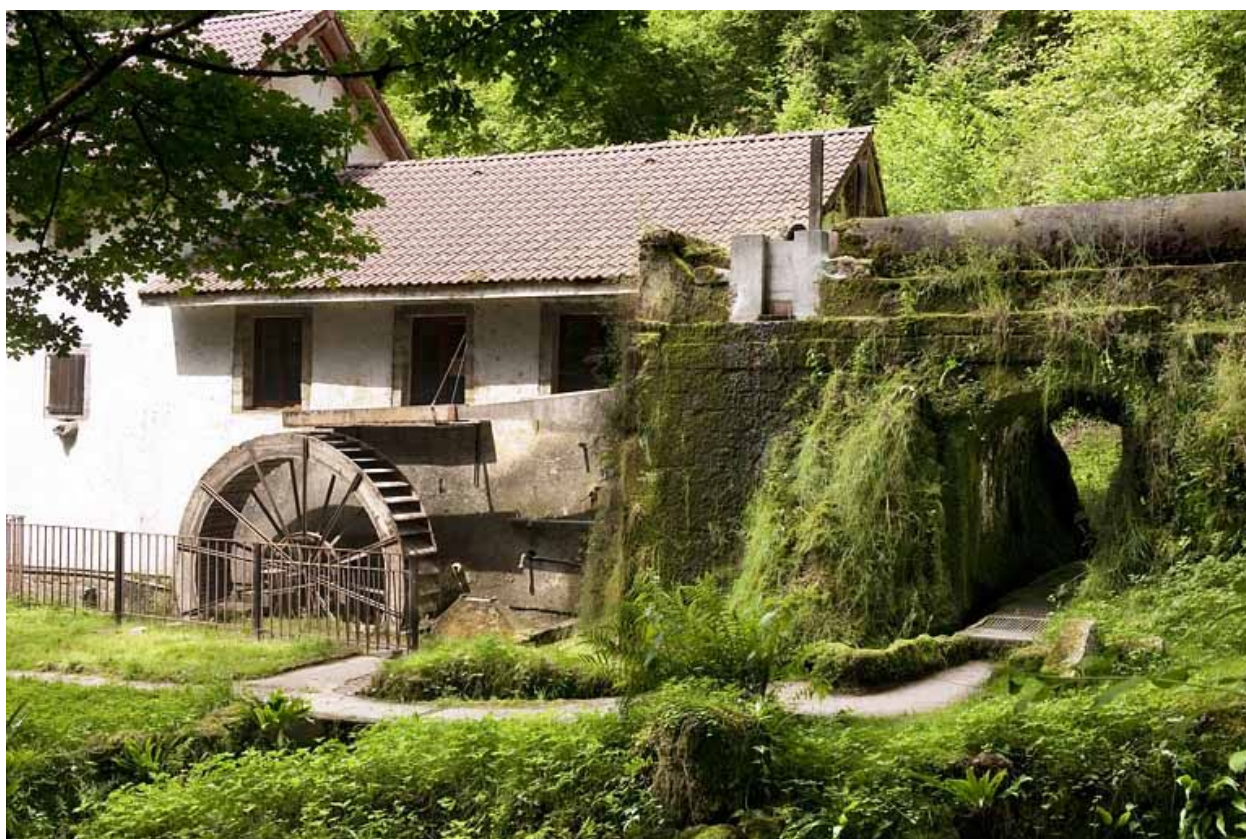
La conduite d'amenée et la roue hydraulique.
