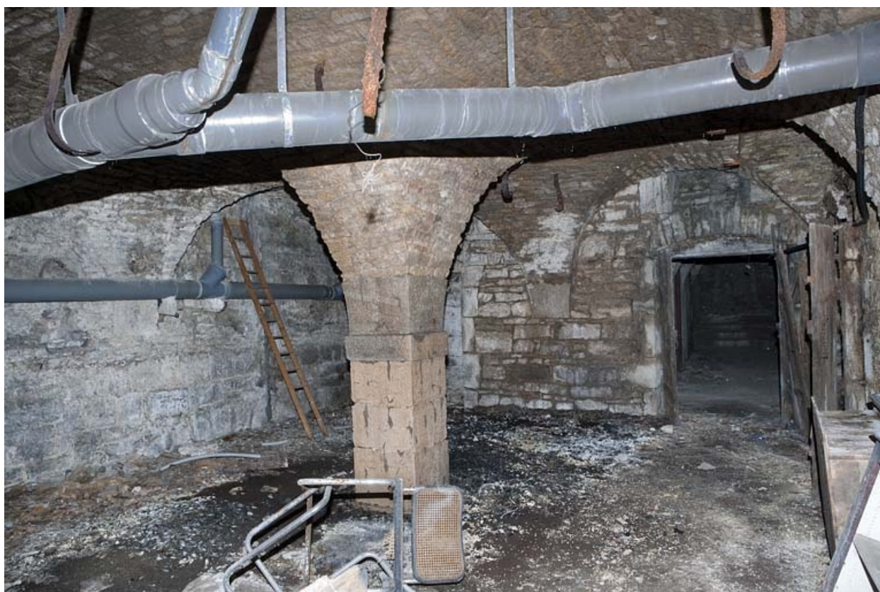
Logis principal, sous-sol : cave B, vue d'ensemble.
