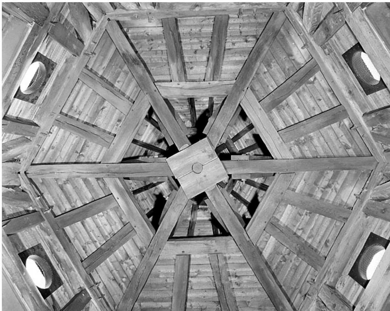
Tour Henriette. Charpente du lanternon.
