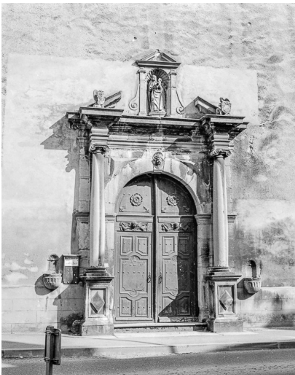
Portail de la façade antérieure : vue générale.
