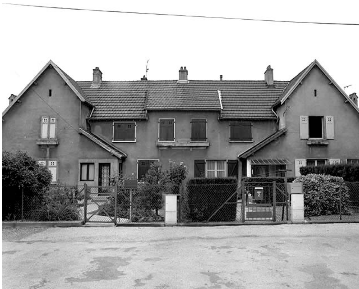
Immeuble de type 1, 2, 4, 6 rue Francis Cussey.
