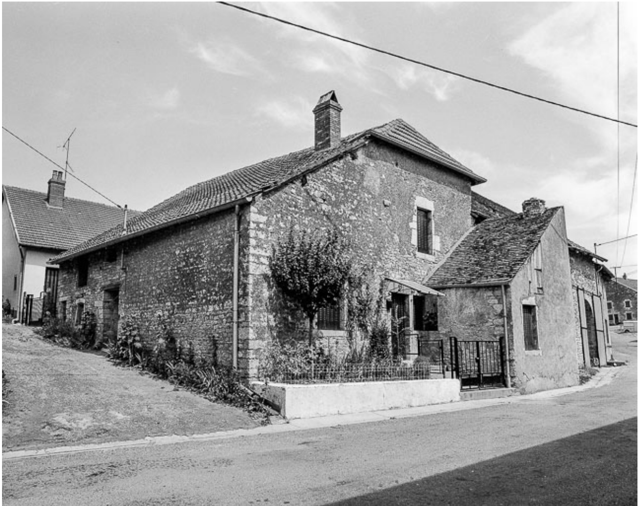
Maison située entre la rue d'Amont et la ruelle des Vignes : façades antérieure et latérale gauche.
