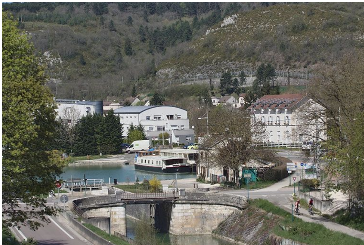
Vue d'ensemble du pont, vu de dessus.
