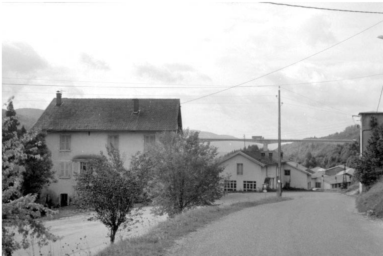
Usines et logement depuis le nord.
