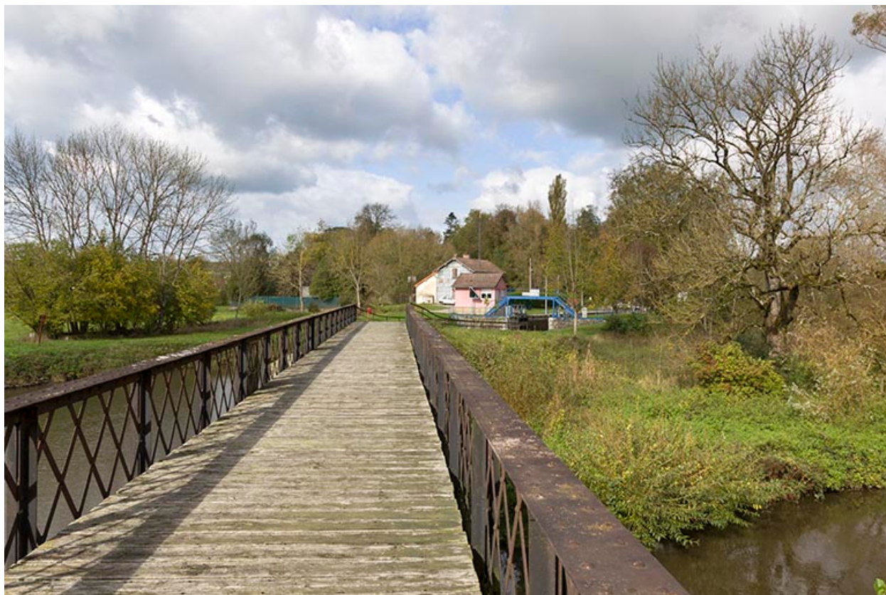
Détail de la passerelle enjambant le Coney.
