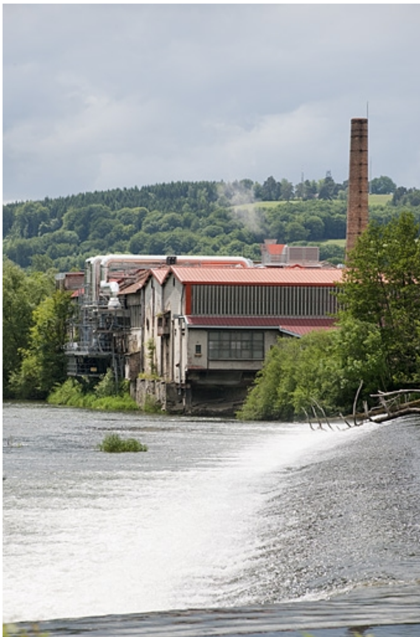
Barrage et bâtiments industriels depuis le nord.
