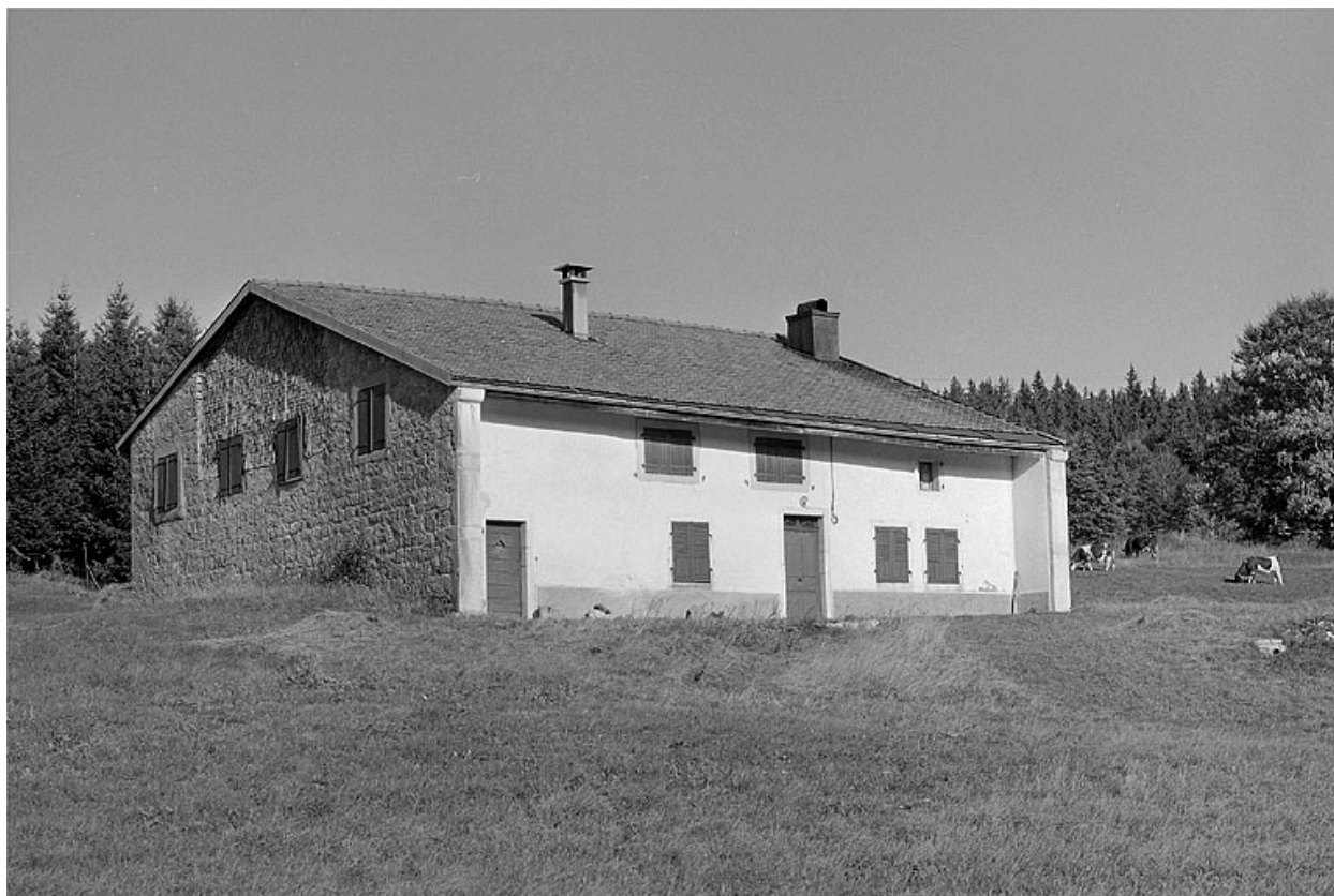
Façade antérieure et face sud-ouest.
