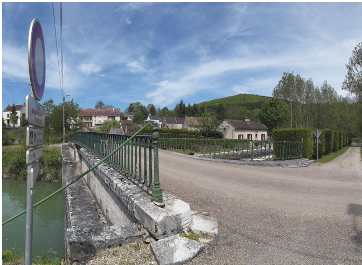
Pont vu d'aval.
