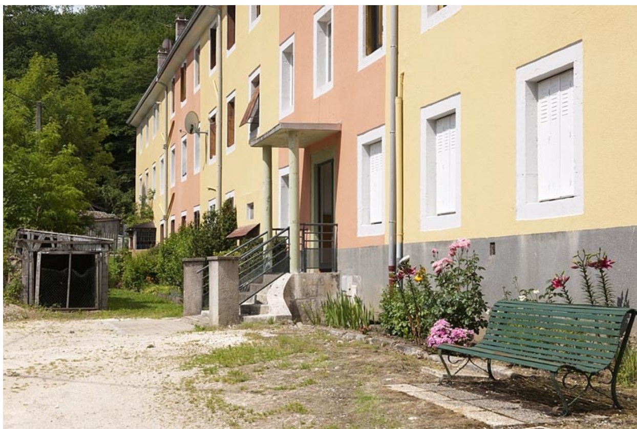
Détail de la façade sud.
