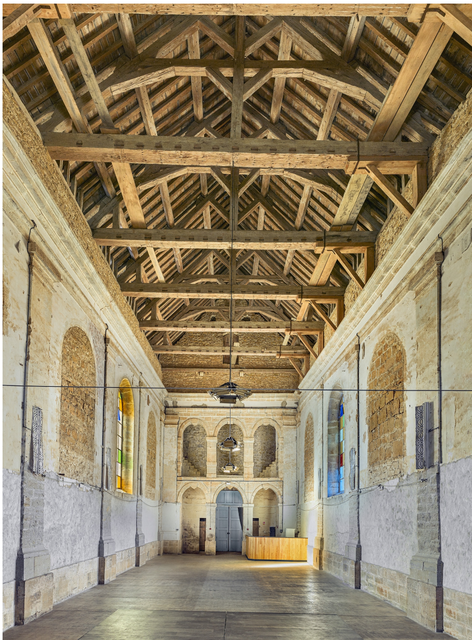
La nef, la charpente et la tribune.
