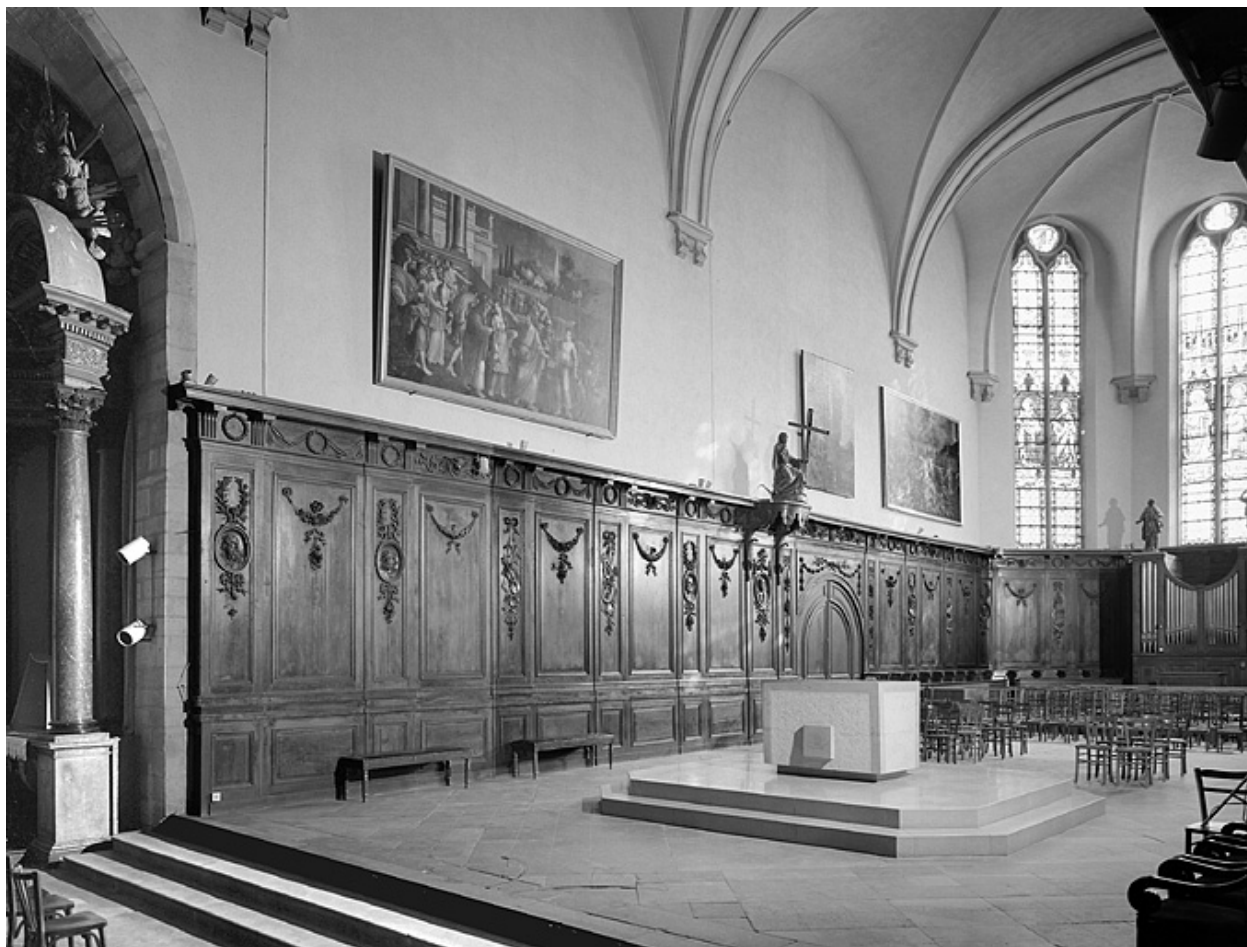
Vue générale du côté nord.
