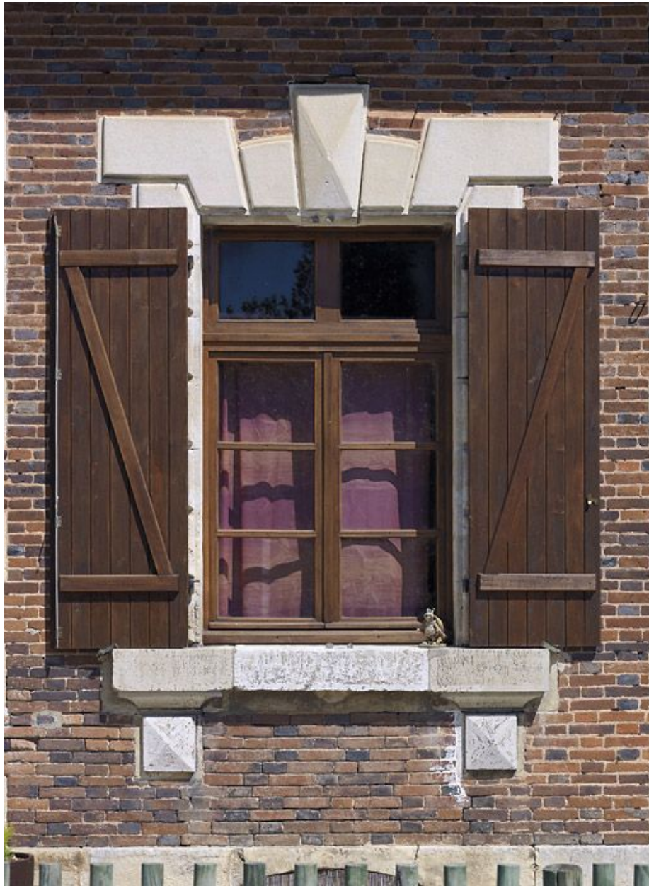
Maison éclusière : détail de la fenêtre.
