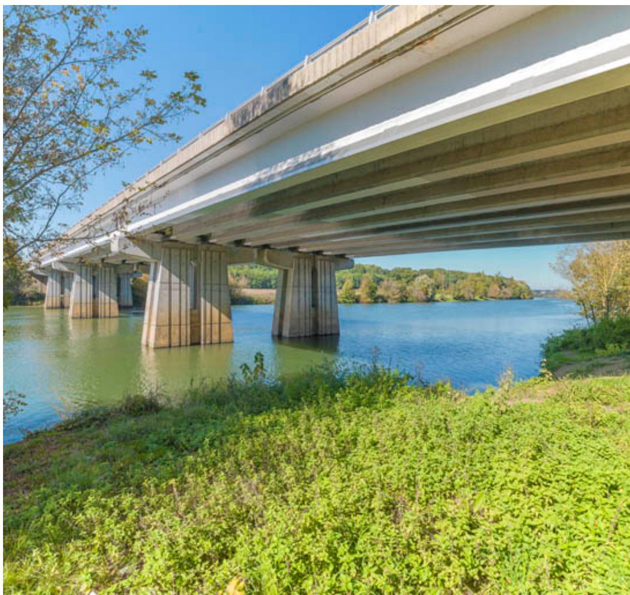
Vue rapprochée des piles et du tablier.
