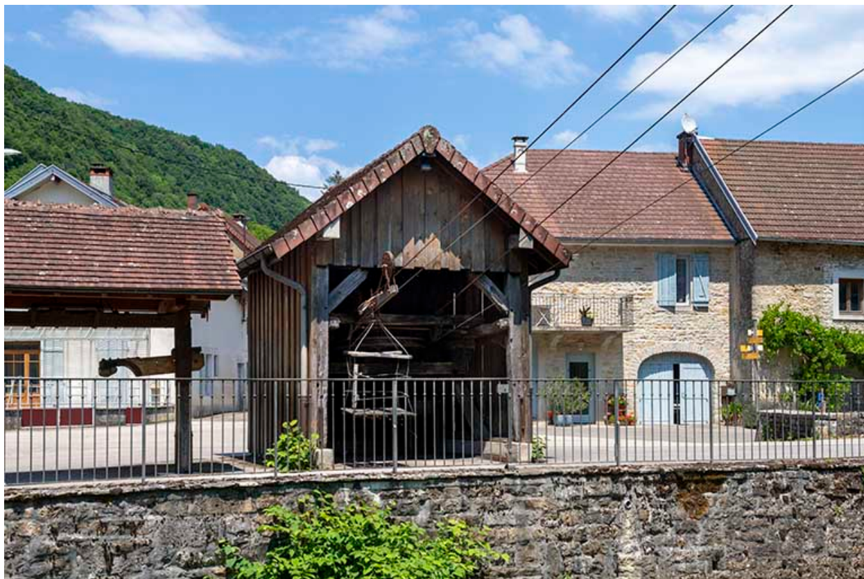
2020. Vue d'ensemble du transporteur automatique par câbles.
