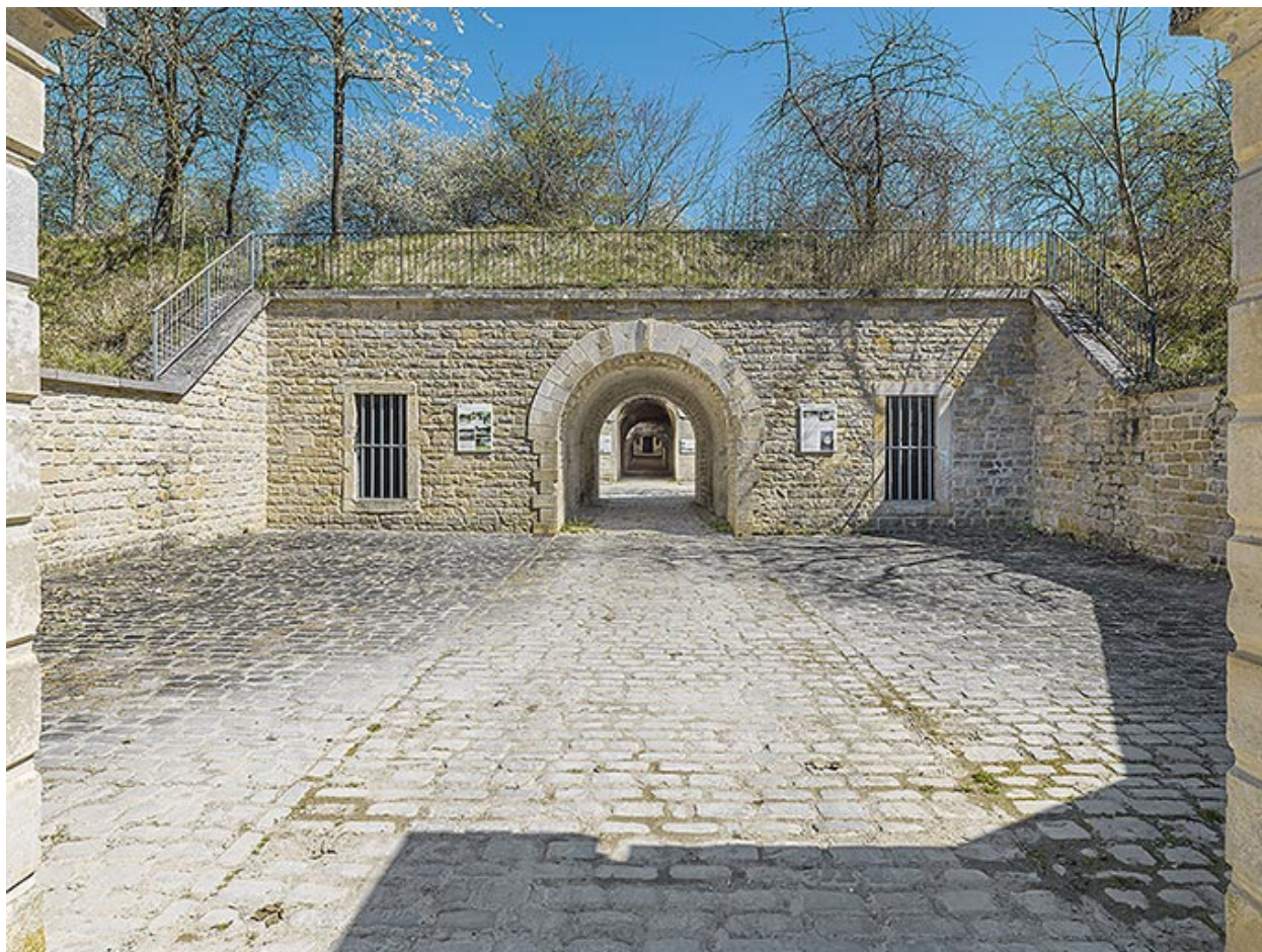
Cour du ravelin défendant l'accès à la redoute.
