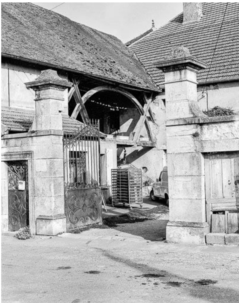
Détail de la partie habitation.
