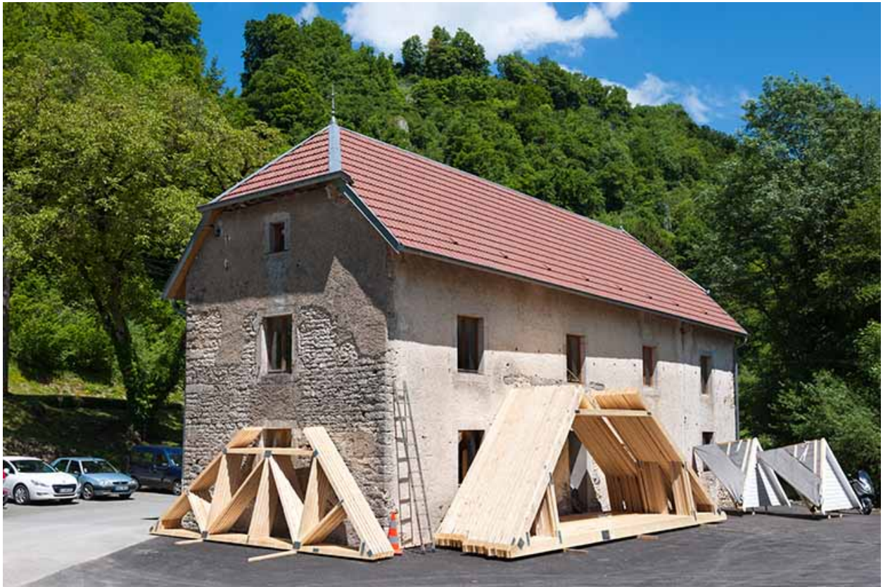
Bâtiment agricole depuis le sud-ouest.
