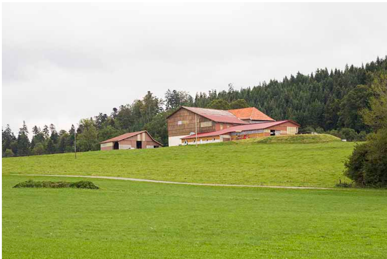
Vue d'ensemble rapprochée, depuis le nord-ouest.
