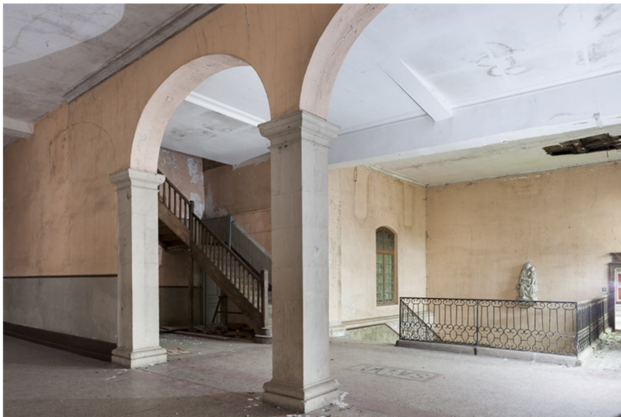
Intérieur : le grand escalier au rez-de-chaussée.
