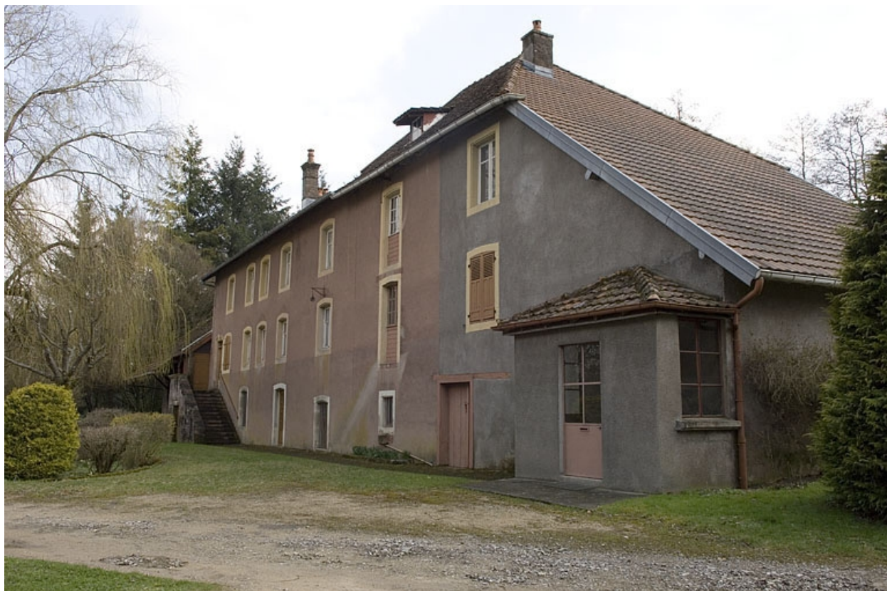
Façade antérieure depuis l'ouest.
