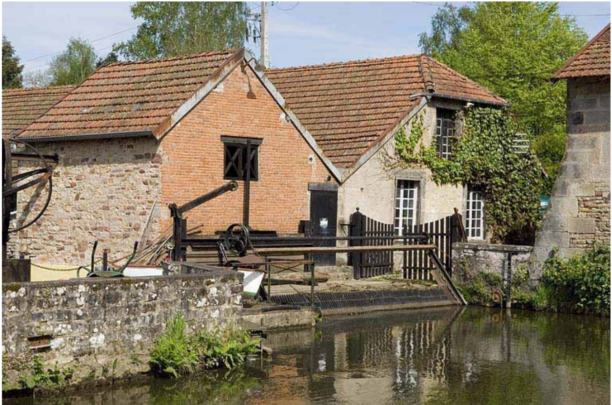
Salle des machines (nord).
