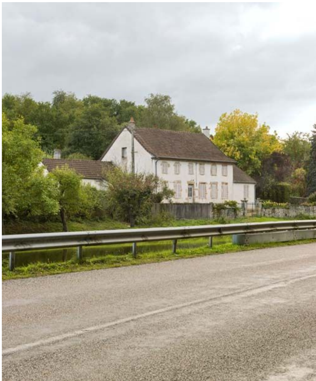
Vue d'ensemble de la demeure et du canal.
