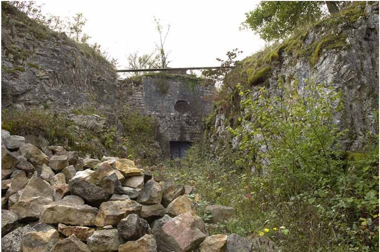
Carrière des Fourneaux, à Sampans : bâtiment (poudrière ?).
