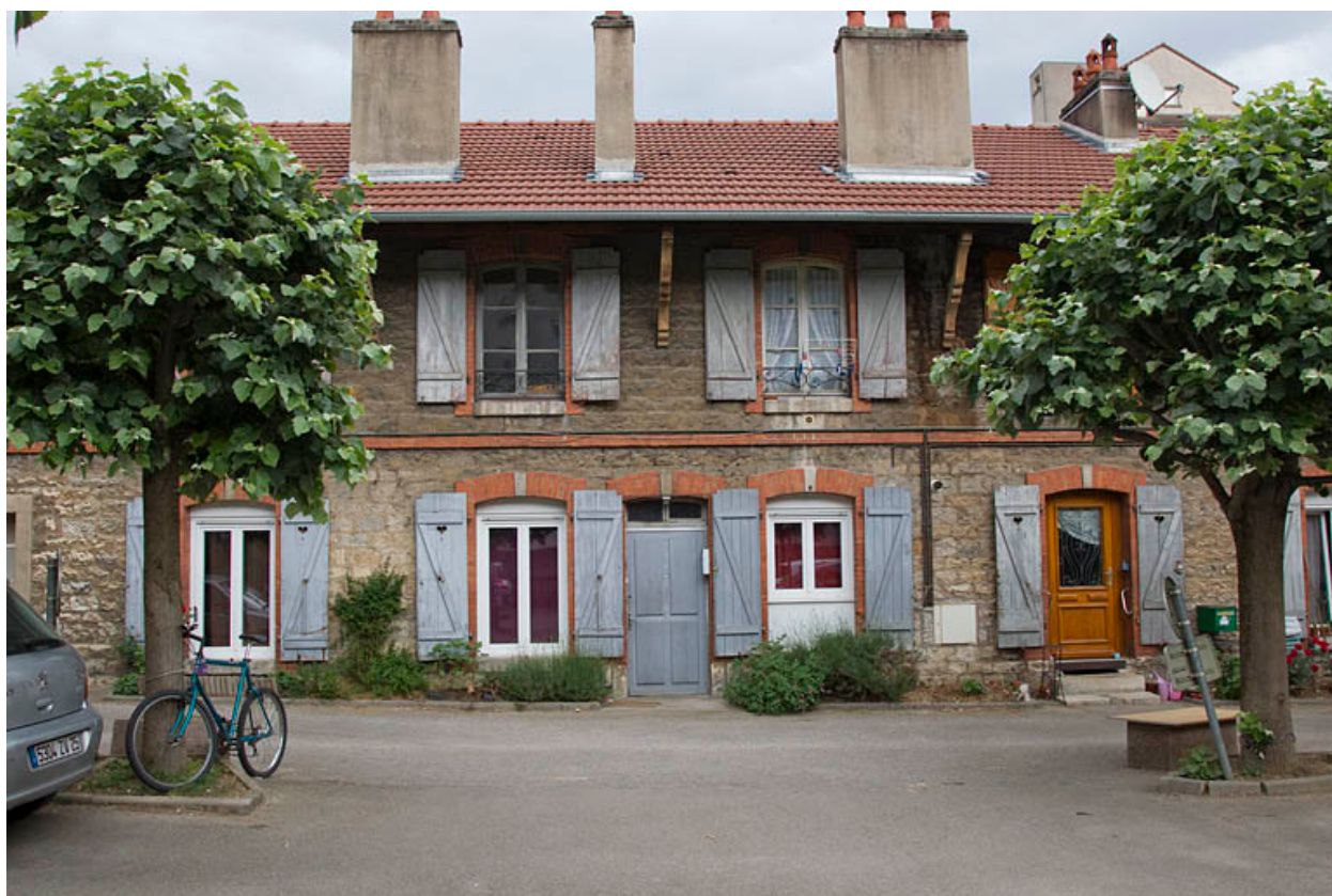
Façade antérieure de la distillerie. Travée des logements (et bureaux ?).
