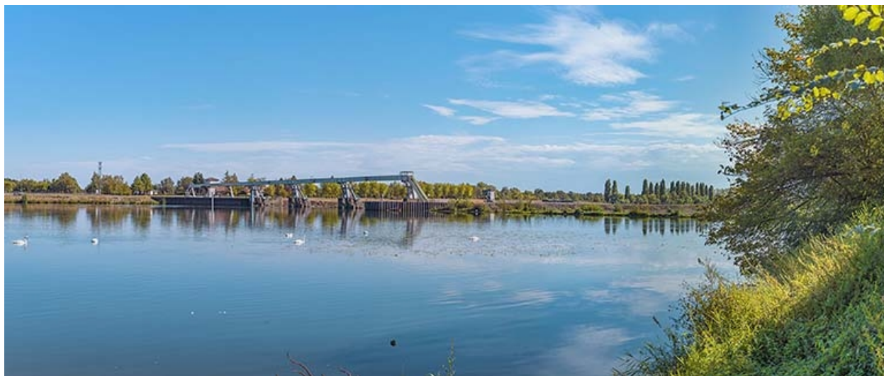
Le barrage, vu d'amont.
