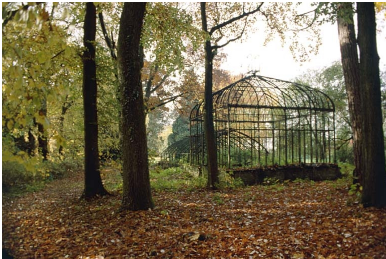
Vue d'ensemble de la serre.
