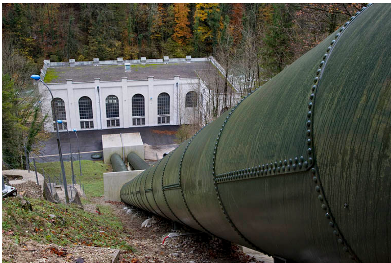
Conduite forcée : vue plongeante.
