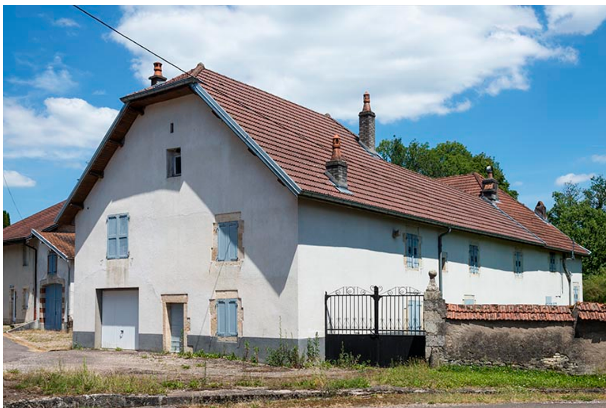
Vue sur la partie sud.
